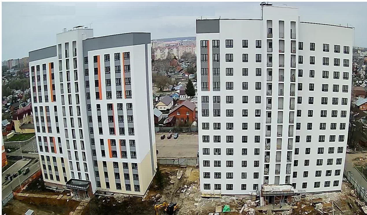
Рис. 7. «Застройка многоэтажными жилыми домами по ул. Филатова (площадки № 1 и № 2 по генплану) в г. Саранске»
