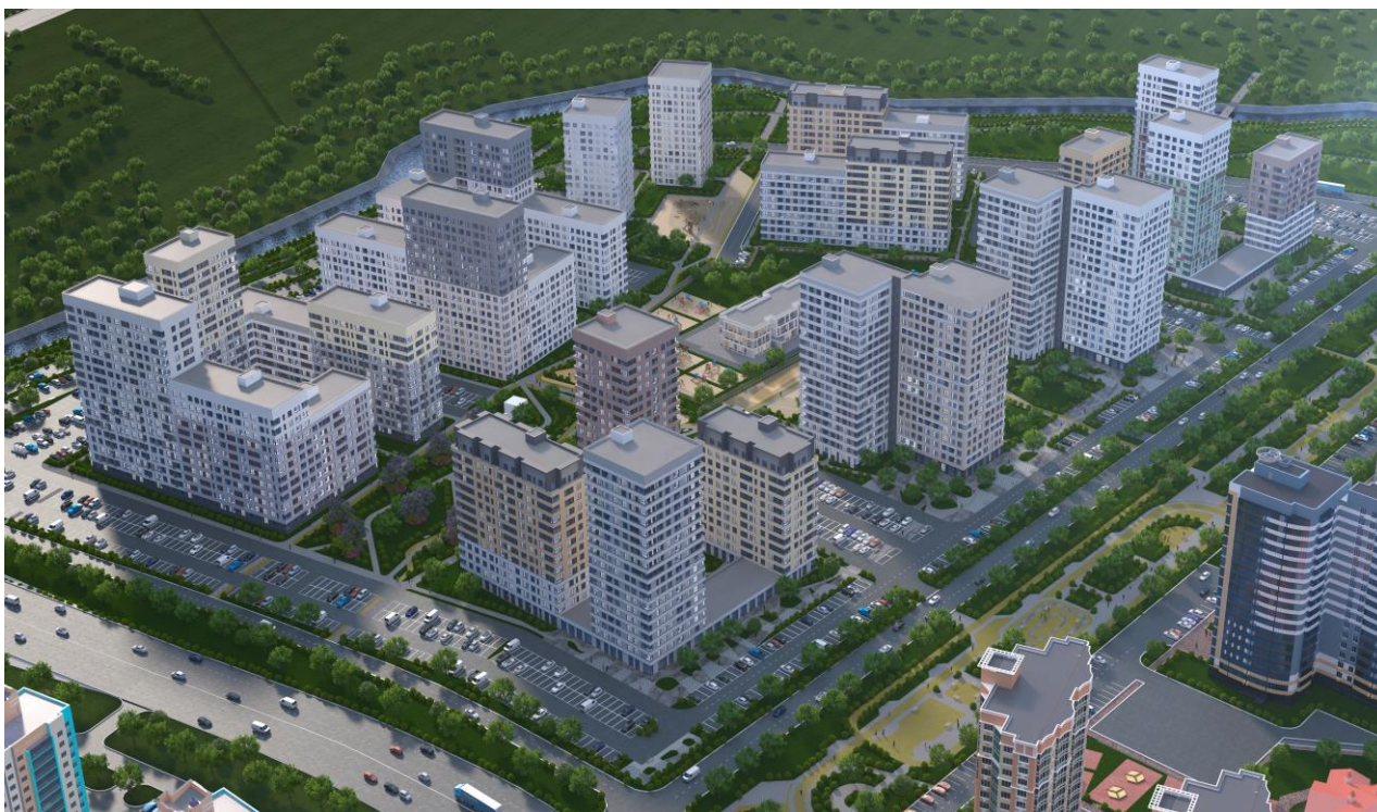
Рис. 6. «Комплексная застройка многоэтажными жилыми домами на участке между ул. Волгоградская и автомобильной дорогой на с. Кочкурово (в районе р. Тавла) г. Саранска. Проект застройки 3-го микрорайона»
